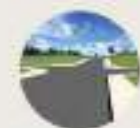
PAVIMENTAÇÃO a meio-fio
